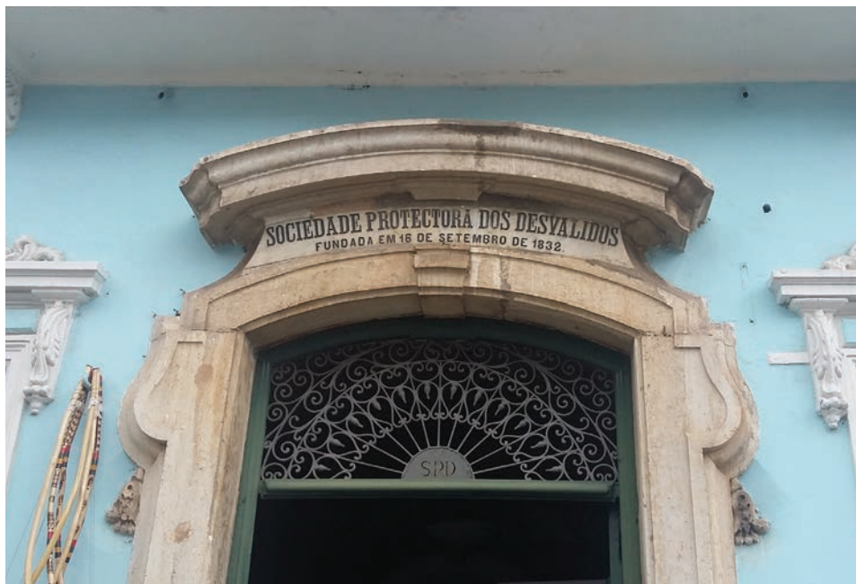
FIG. 4: Detalhe da fachada da SPD.
